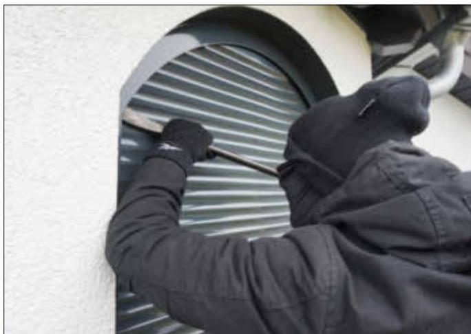
einen deutlich höheren Einbruchschutz als die einfachen Varianten aus Kunststoff, die sich leicht aus den Führungsschienen drücken und hochschieben lassen. Die stranggepressten Aluminiumprofile sind etwa zehnmals belastbarer als marktüblich ausgeschäumte Rolladenstäbe. Der Einbau von Sicherungen und elektrischen Motorantrieben erschwert das Hochschieben zusätzlich. In
