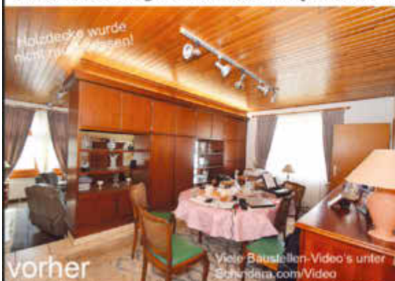
Vorher: Wohnzimmer mit Holzbalken und Holzdecke. Die Decken waren gut erhalten und konnten somit als Unterkonstruktion wiederverwendet werden. Video zur Baustelle: Schindera.com/Esszimmer
