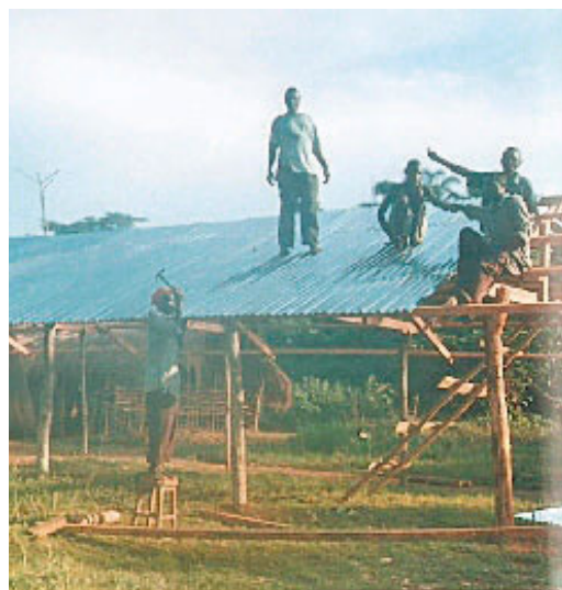
Foto rechts: Das wetterfeste Schuldach
